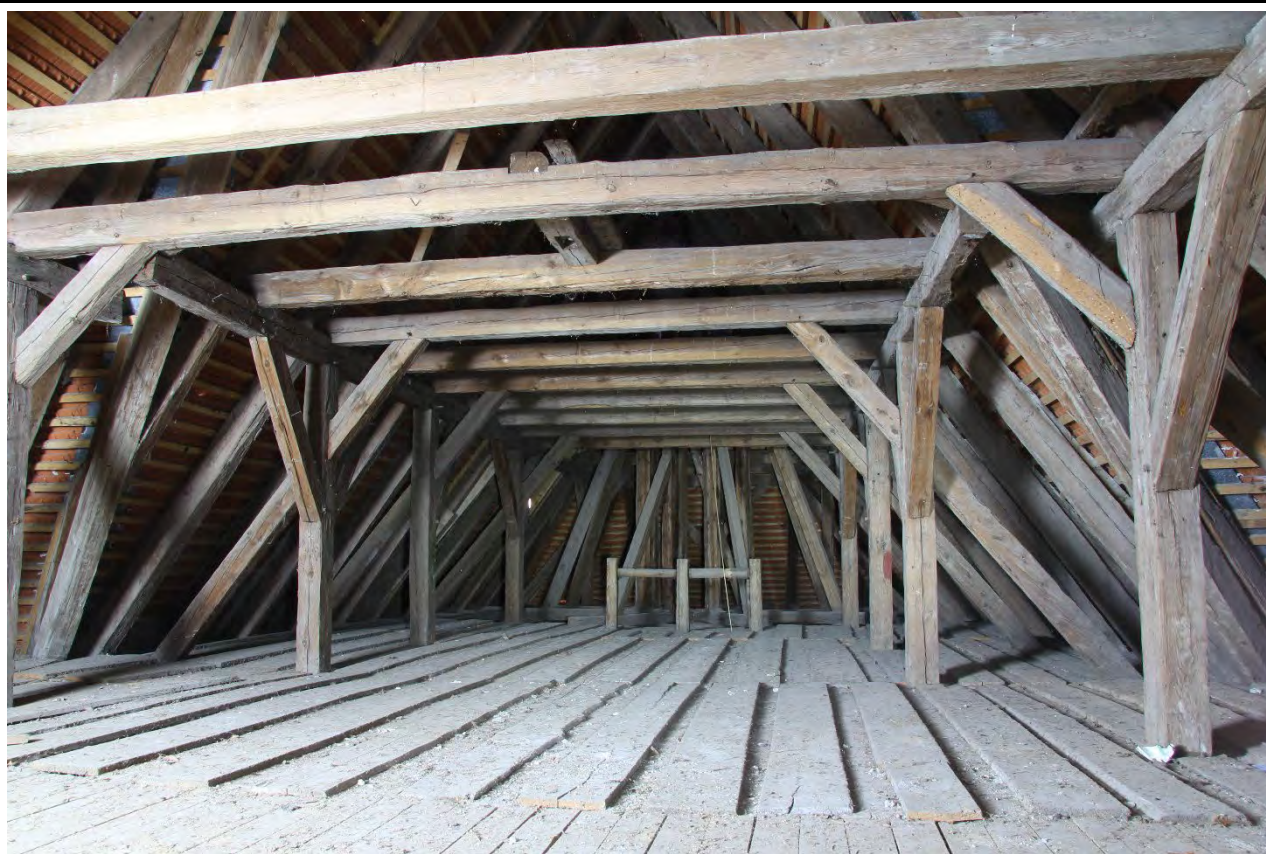
Krov nad lodí s pohledem k východu. Foto: Jaroslav Skopec, 2021.
