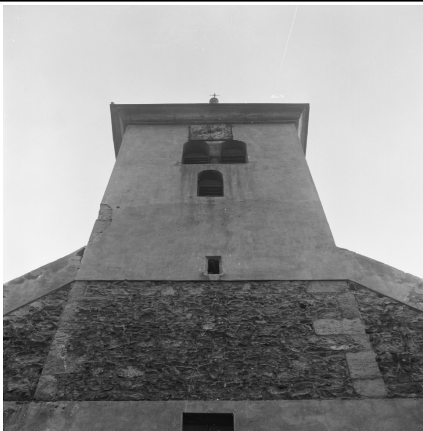
Západní průčelí věže z pohledu od západu. Foto: 1968, sbírka negativů NPÚ ÚOP v Ústí n. L., sign. 33386.
