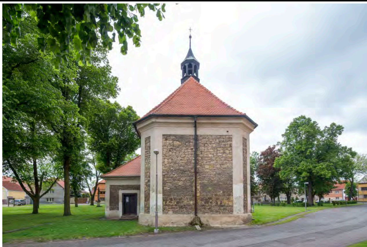
Východní průčelí presbytáře. Foto: Marta Pavlíková, 2014.
