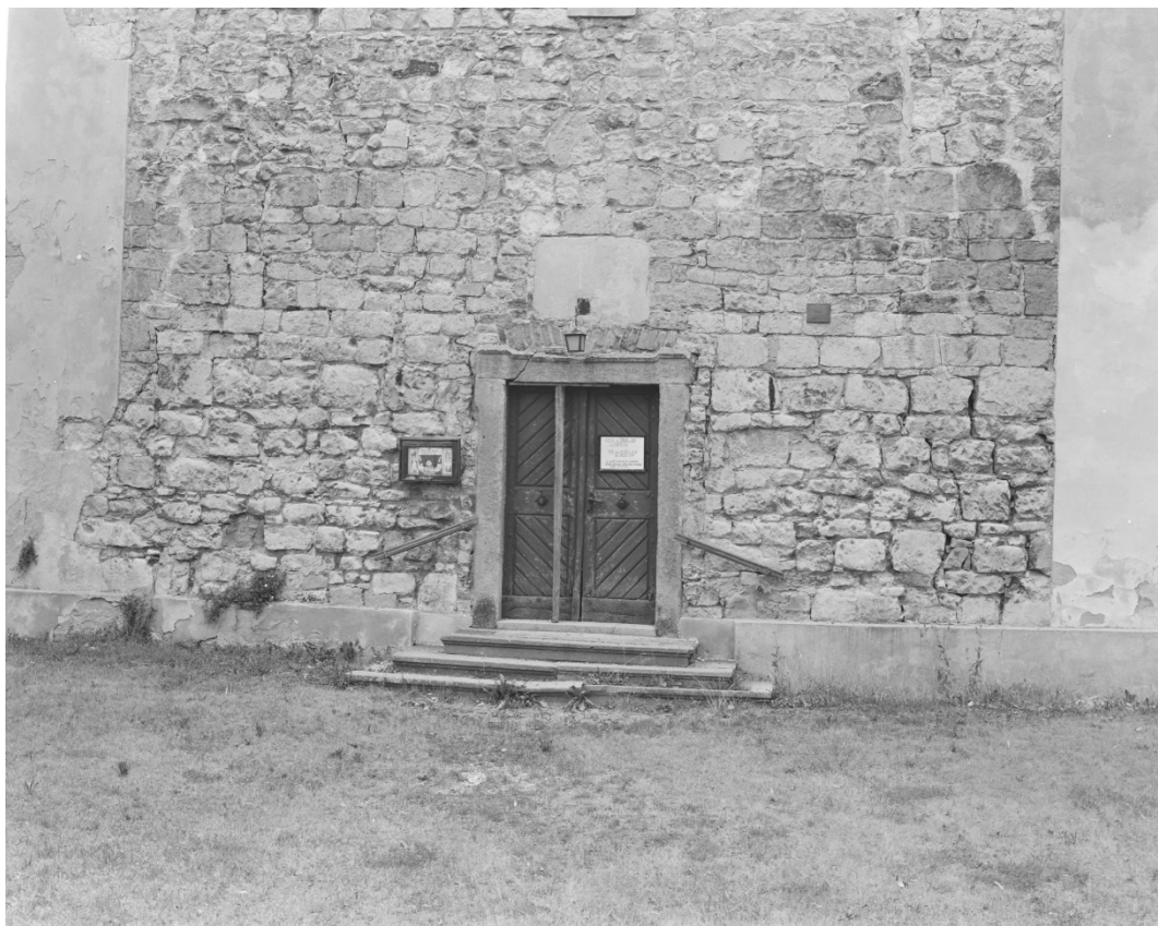
Spodní úroveň západního průčelí. Foto: 2006, sbírka negativů NPÚ ÚOP v Ústí n. L., sign. 179461.
