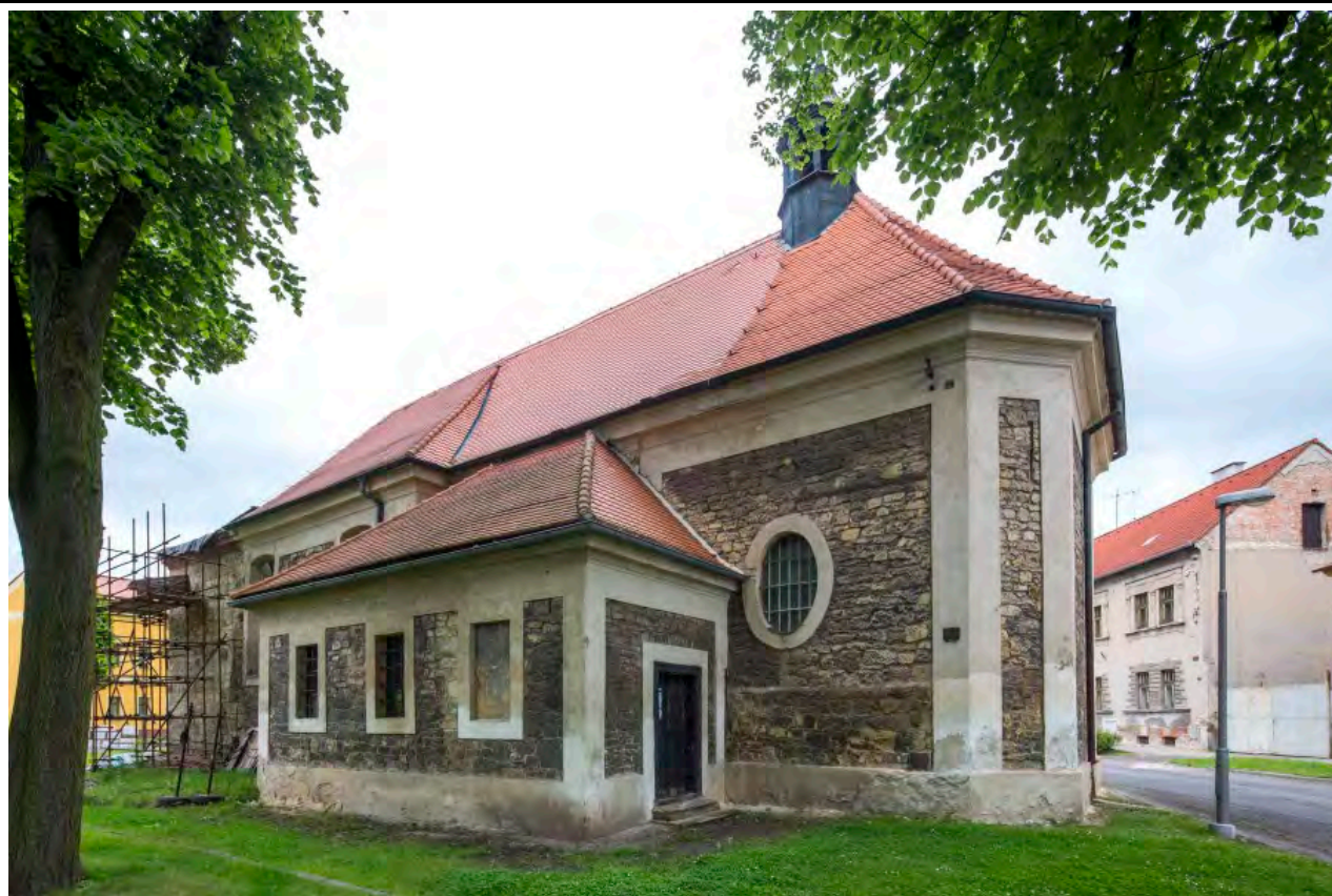
Celkový pohled od jihovýchodu. Foto: Marta Pavlíková, 2014.
