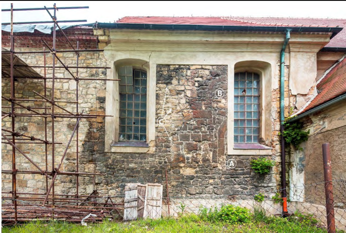
Jižní průčelí lodi v pohledu od jihu. A – Částečně dochované ostění pozdně gotického portálu směřujícího na kruchtu. B – Zazděný a částečně dochovaný románský půlkruhový okenní otvor. C – Zazděný hrotitý okenní otvor s úseky méně zřetelných spár. Foto: Marta Pavlíková, 2014.
