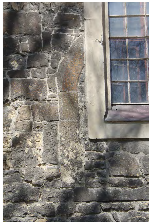
Detail zazděného portálu na kruchtě na jižním průčelí lodi. Foto: Jaroslav Skopec, 2021.
