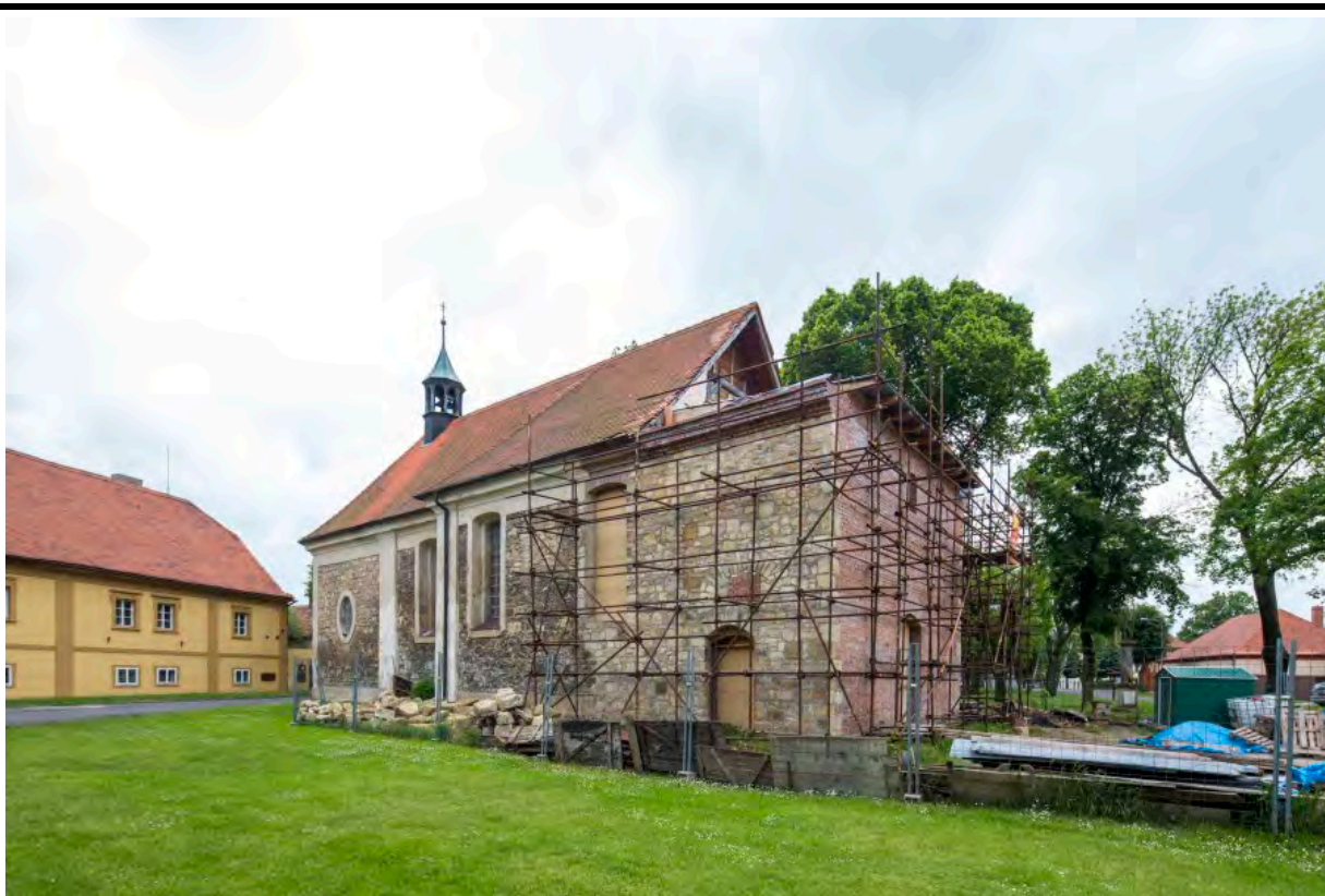
Celkový pohled od severozápadu. Foto: Marta Pavlíková, 2014.
