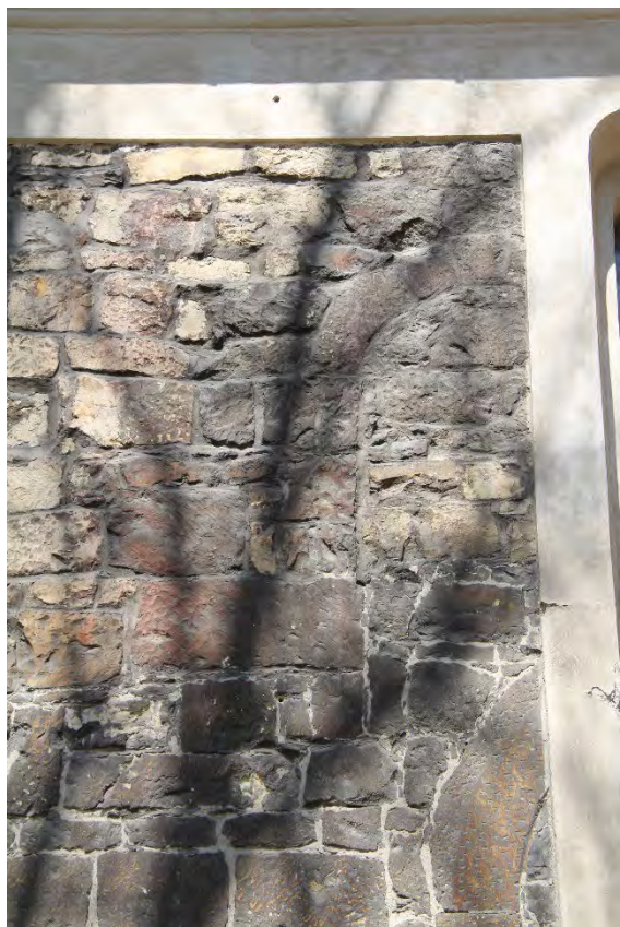
Detail zazděného románského okenního otvoru na jižním průčelí lodi. Foto: Jaroslav Skopec, 2021.
