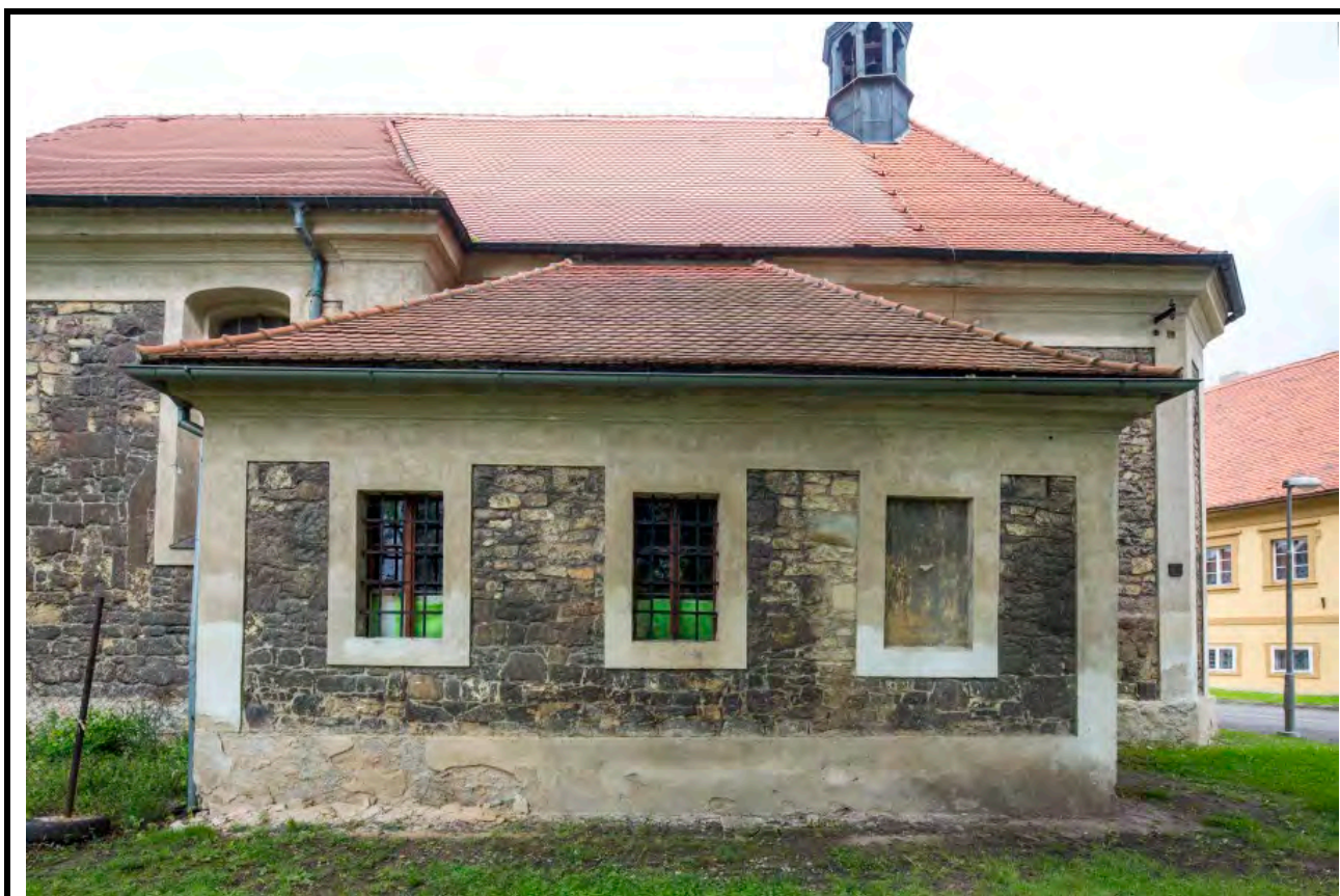
Jižní průčelí sakristie. Foto: Marta Pavlíková, 2014.
